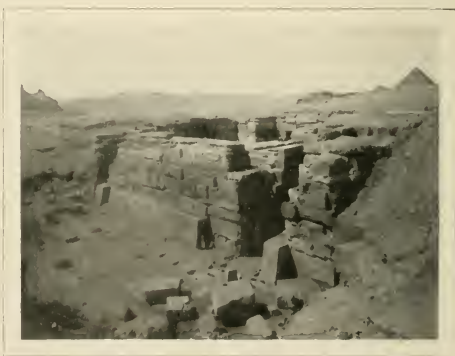
FIG. 87. — LA FAÇADE DU TEMPLE DU SPHINX. (Cliché Steindorff)
